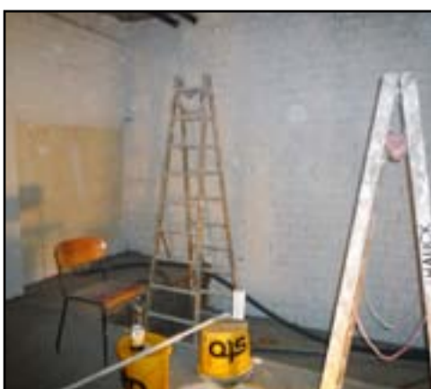
Bild 1: Der URZ-Maschinensaal im Untergeschoss wird modernisiert und umgebaut. Die Wand auf dem Foto wurde neu eingezogen. Foto: Duwe
