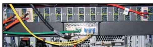
Netzwerkkomponente der Firma Obsidian für die Umsetzung Infiniband auf Licht. Foto: Dr. Heinz Kredel
