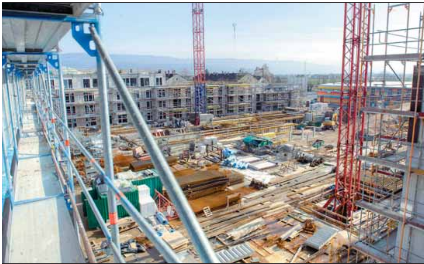
Bis 2012 entstehen am Kranichweg/Steinhofweg im Pfaffengrund 147 neue Wohnungen, an denen im Moment 124 Handwerker arbeiten. Bereits im September 2011 soll das Pflegeheim (links im Bild) bezugsfertig sein. Fotos: Stefan Kresin
