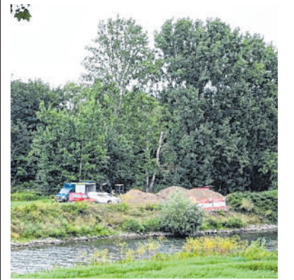
Bei Bauarbeiten in Feudenheim wurde die Weltkriegsbombe entdeckt. BILD: PRIEBE
