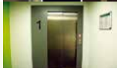
Aufzug elevator 电梯 مِصْعَد
