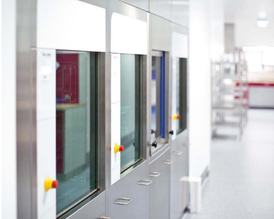
Auch in die Planung medizinischer Gebäude ist die Stabsstelle Krankenhaushygiene eingebunden.
