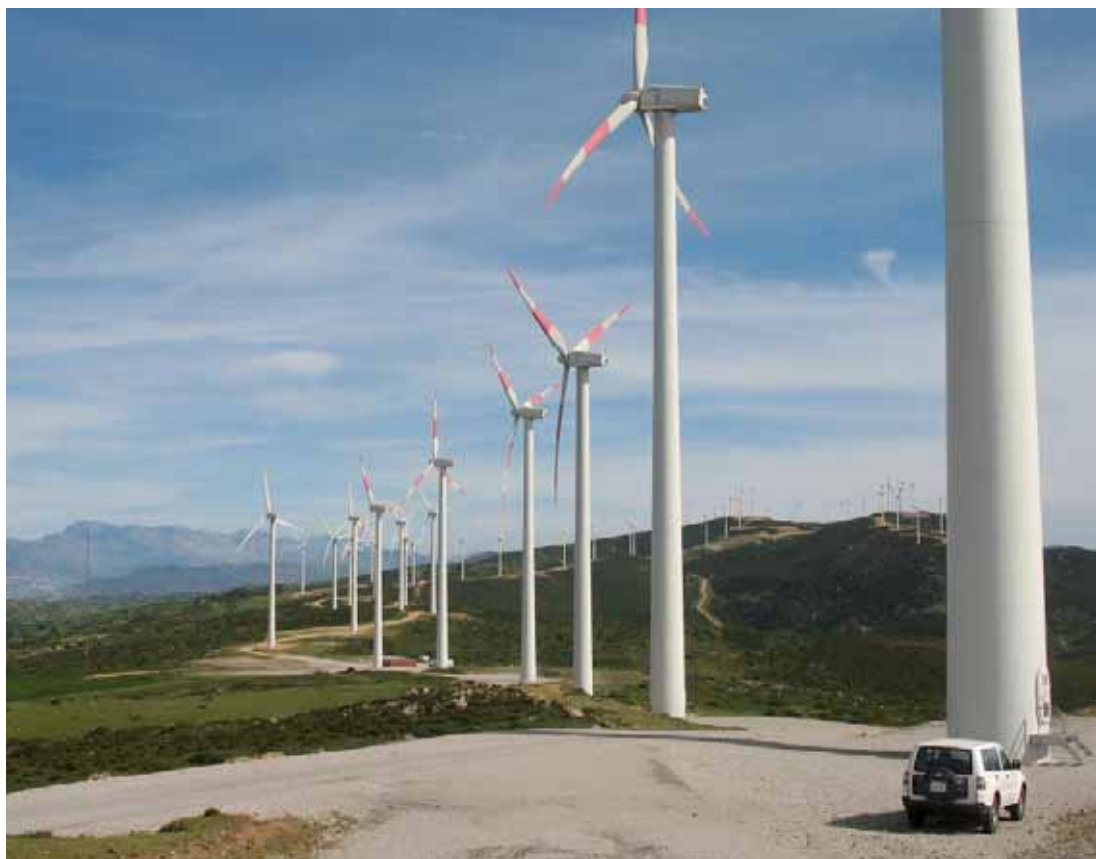
Foto 1: Der Windpark Tanger I in Marokko ging 2009, eine Erweiterung 2011 in Betrieb. Er umfasst 145 Windräder mit einer Gesamtleistung von 140 Megawatt
