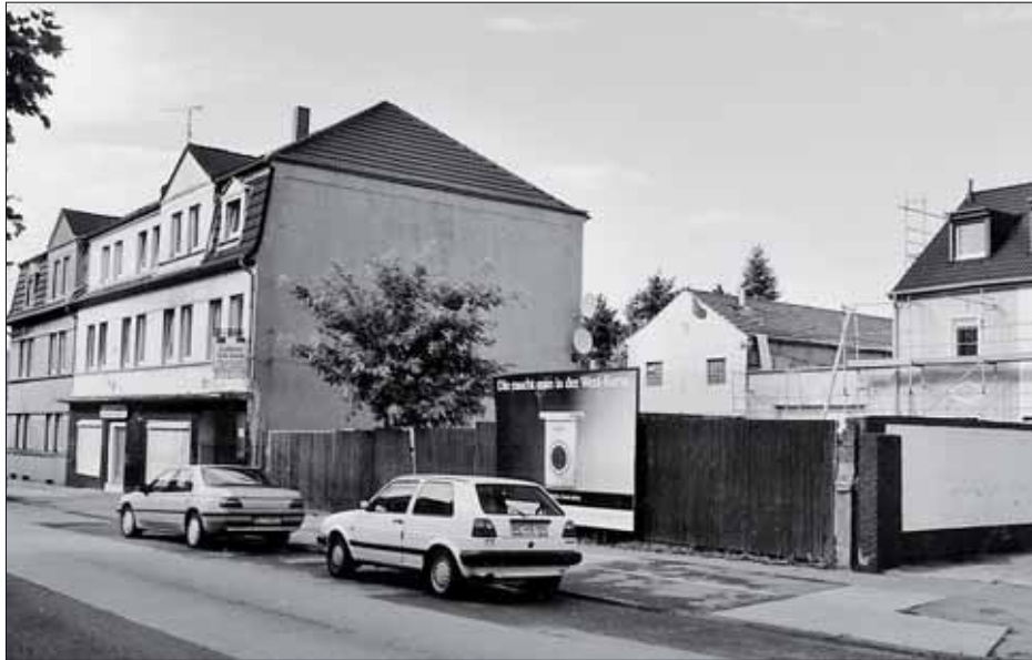
Abb. 2-1: Blick auf das frühere Moschee-Gebäude in Gladbeck-Butendorf
