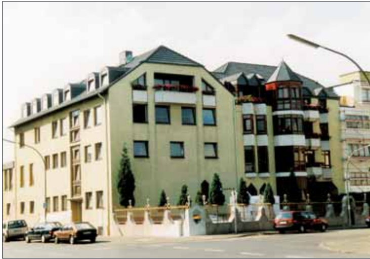
Abb. 5-18: Außenansicht der Bundeszentrale des VIKZ in Köln
